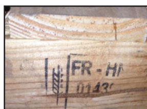
Marcas inaceptables (Ilegible)
